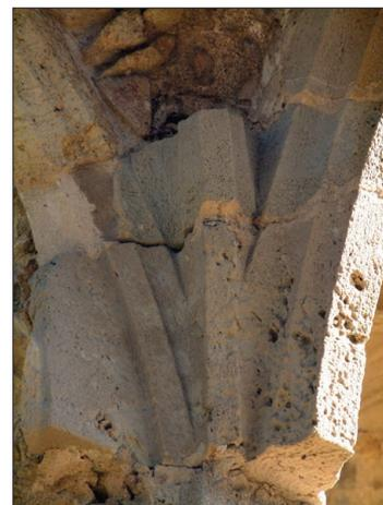
Fig. 26. Fracturas originadas por desequilibrio estructural.
