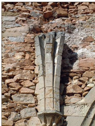
Fig. 2. Arranque de las nervaduras de las bóvedas.
